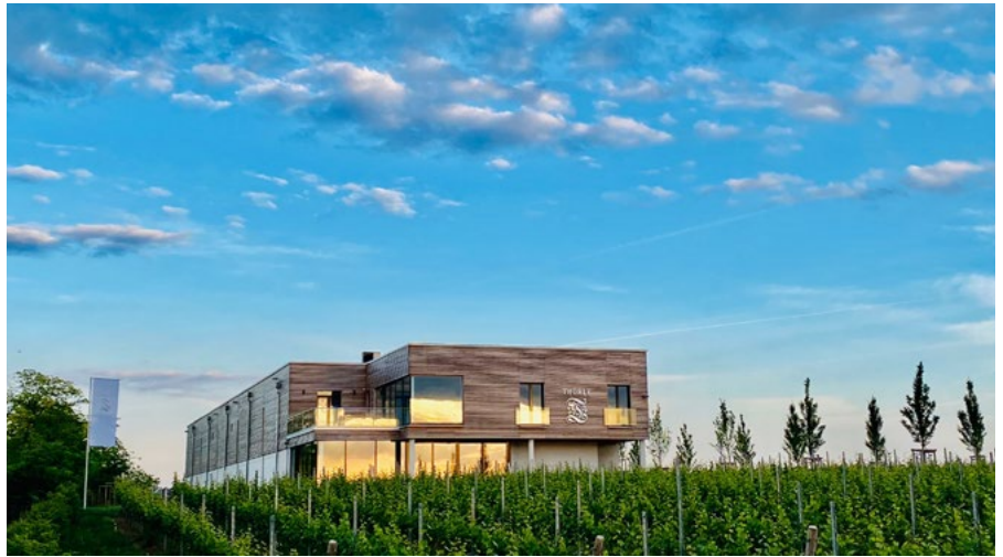
Weingut Thörle, Saulheim/Rheinhausen: 2019 errichteten die Brüder Christoph und Johannes Thörle in den Weinbergen bei Saulheim ihr neues Betriebsgebäude. Neben modernster Kellertechnik gibt es auch eine Vinothek – mit spektakulärem Fernblick.
